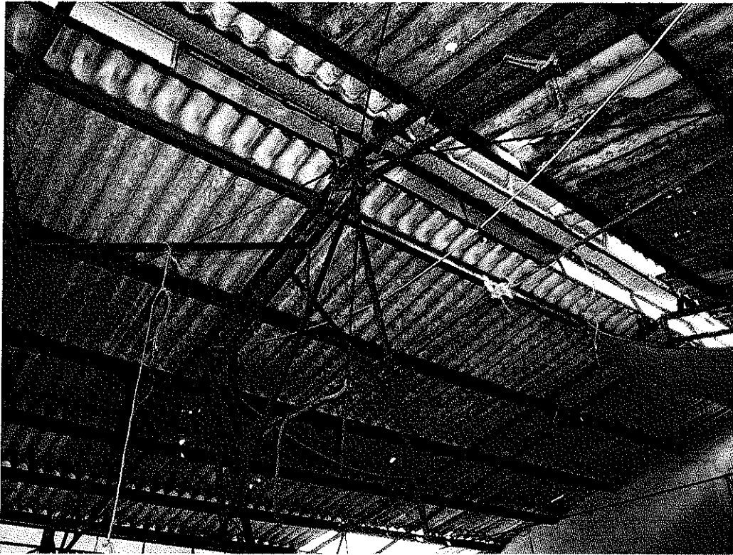
COPERTURA IN ETERNIT
