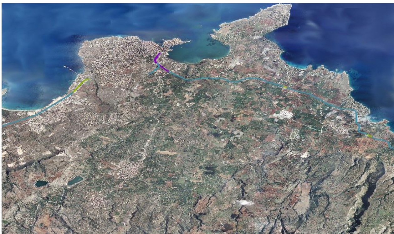
Fig. 2.4 – layer vettoriale\ relativo agli assi ferroviari (Catania-Siracusa-Gela): tratto di linea tipo I (celeste), tipo II (verde), tipo III (viola).
