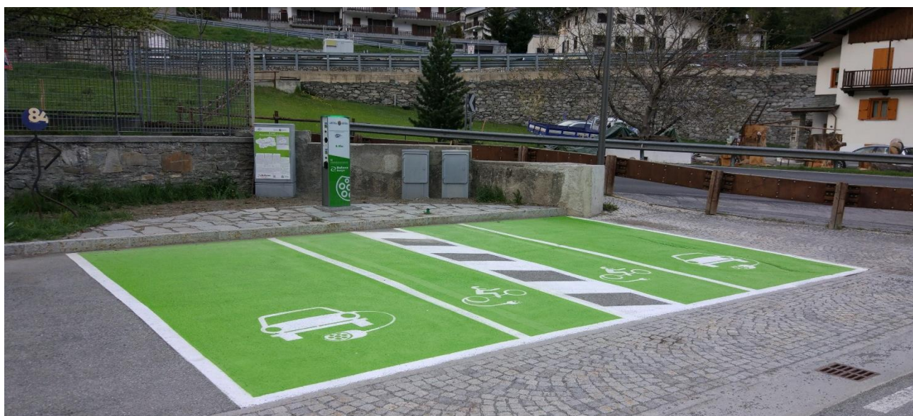
Figura 3 _ Foto di Installazione infrastruttura Quick Charge - Comune di Aosta (VA)
